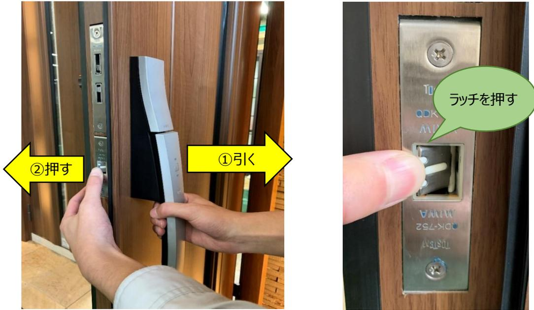
4 : ラッチ部を指で押さえながら手順2と同じ様にラッチ開口部(斜線の部分)を矢印の様な状態にしてください。
