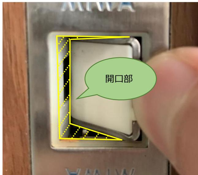
3 : ドアを開けた状態でハンドルを矢印の方向に引いたまま(室内側の場合は押す)、指でラッチ部を押して右の写真の状態にしてください。
