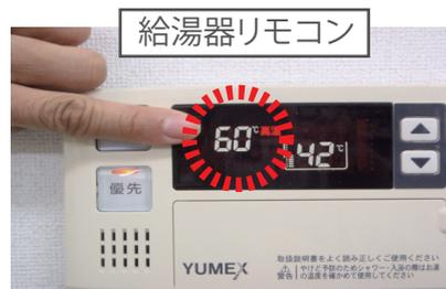
⇒サーモスタット混合水栓は構造上、必要とする温度の+10℃高めの給湯器温度設定が必要です。給湯器の温度設定が低い場合は湯の量が減り、湯水の出が悪くなります。
